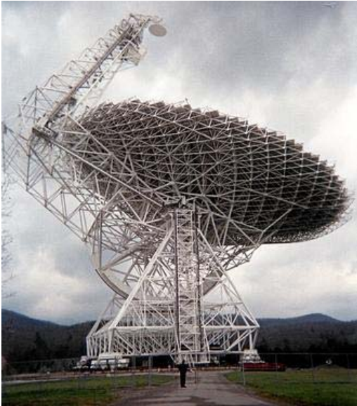
GBT, Green Bank (EE.UU.), 100 m
