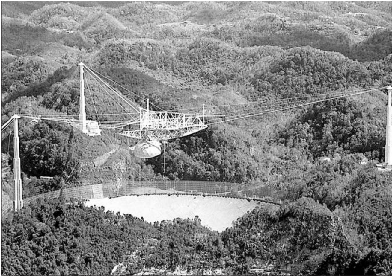
La antena de 305 metros de diámetro del radiotelescopio de Arecibo (Puerto Rico) está montada entre montañas (izquierda). A la derecha, detalle del nuevo instrumento de observación ALFA. / ASSOCIATE PRESS
